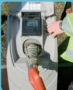
➔ L'ouverture du clapet en plastique provoque la fermeture de l'eau.
